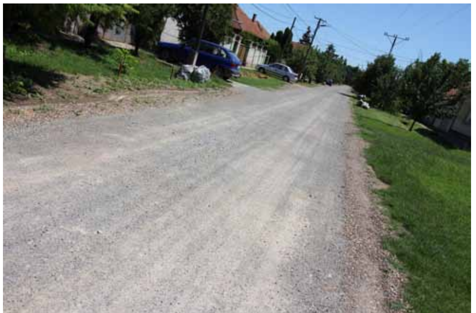
A Tóth utcán késő tavasszal készült el az új, szép és erős útalap. Remélhetőleg pályázati pénzből aszfalt is kerül majd rá.
