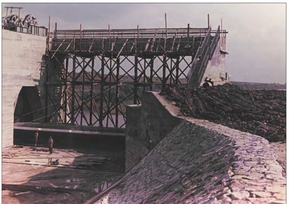
A duzzasztómű nyílásainak kivitelezése a folyószint felett
