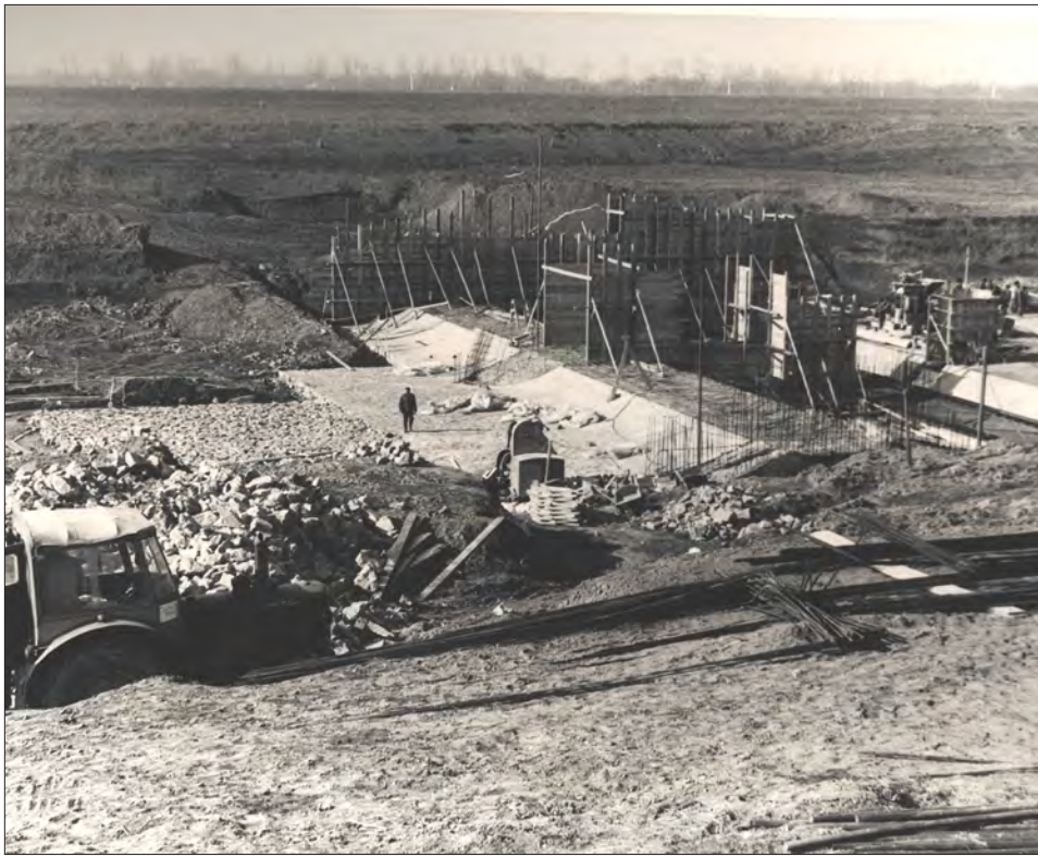
A duzzasztómű vasbeton alapszerkezete
