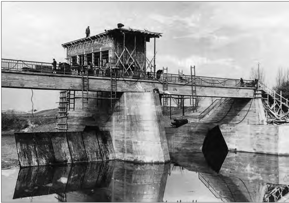
A mederpillér a rajta lévő gépházzal, az építés utolsó szakaszában
