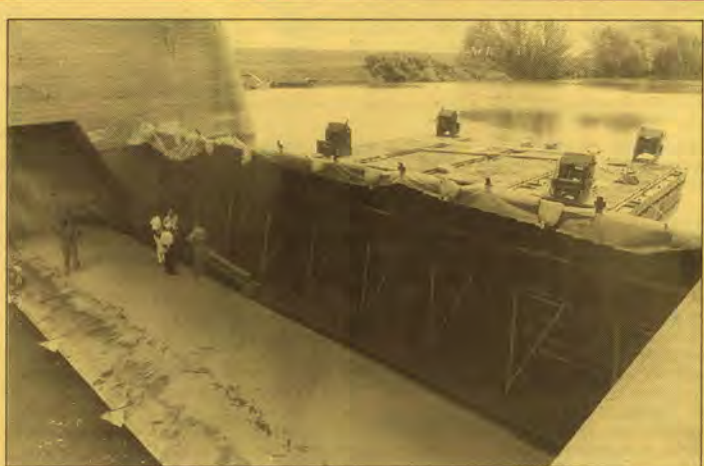
A lenyitott zsilipkapu, az ideiglenes lezárás mintegy 5 millió köbméter vizet tart a Kettős-Körös felső szakaszán
